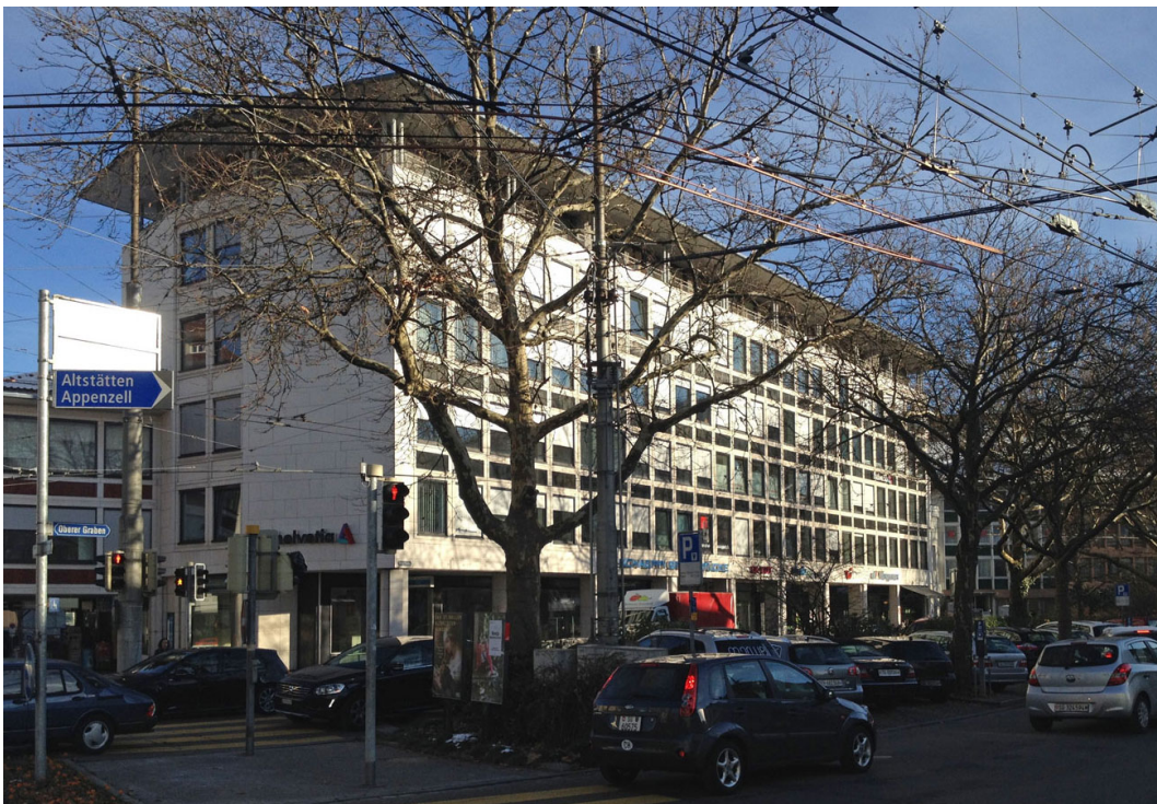
Abb. 35: Ansicht vom Schibenertor nach Südosten.
